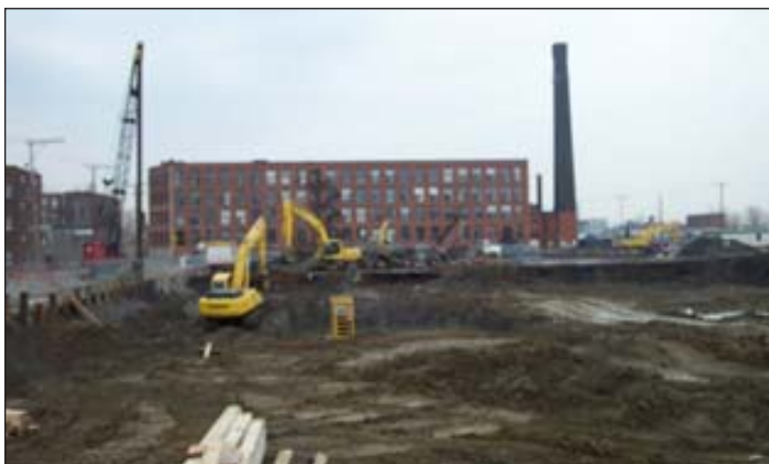
Figure 2: Site excavation, Quai des Éclusiers Credit: Développements des Éclusiers inc.
