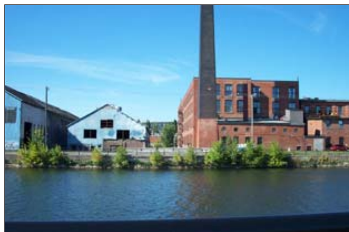
Figure 3: Original Foundry Building Credit: Développements des Éclusiers inc.
